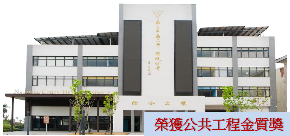
圖 4-33：南投分部綜合大樓獲行政院公共工程委員會第 24 屆金質獎
