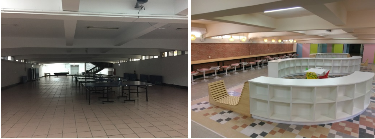
宿舍地下室活動空間整修前後對照圖
